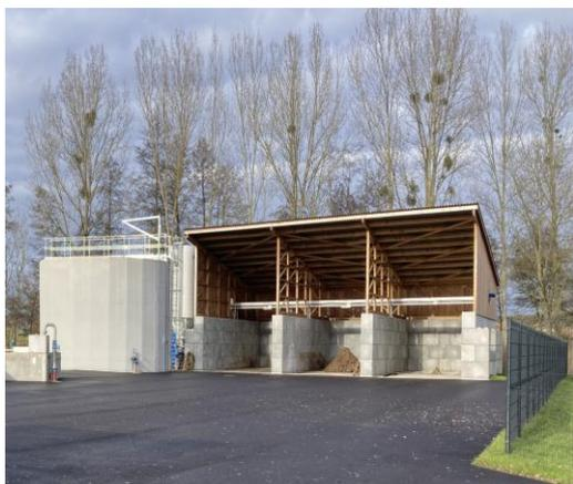
Après 45 années de bons et loyaux services, la station a eu besoin d'une mise à niveau. Une mise aux normes obligatoire est nécessaire avec un nouveau procédé par déshydratation, chaulage et stockage des boues sèches pour :
