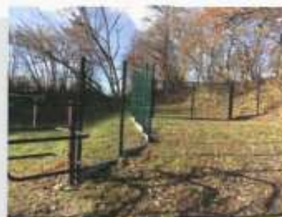
Travaux à l'aire de jeux
