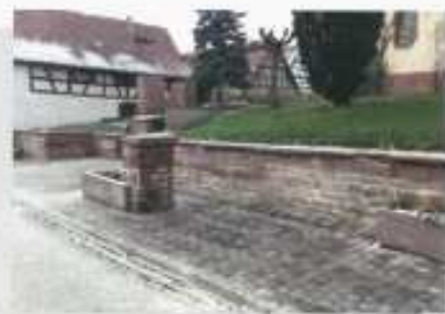
Mur de l'église (2è phase)
