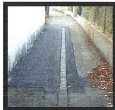
Création d'un fil d'eau, rue de l'église à Zutzendorf
