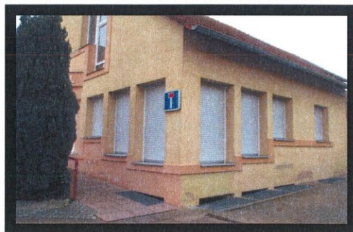
Remplacement des volets roulants au centre culturel
