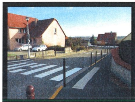
Mise en place de potelets de sécurité devant l'école de Zutzendorf
